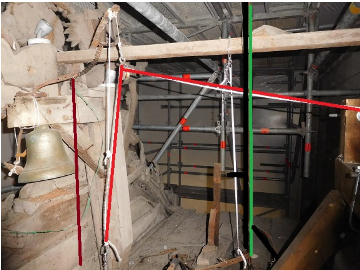
En rouge la sonnerie horaire, en vert les ½ heures, en marron (rompue) les 1/4, et en noir la commande du jacquemart.
