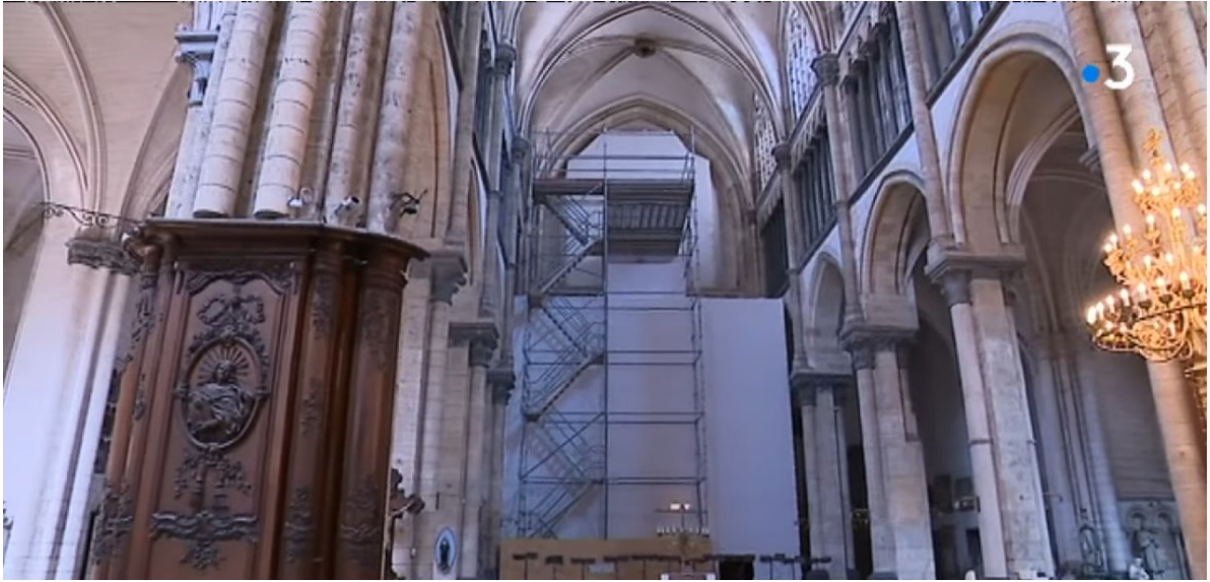
Vue générale de cet échafaudage cocon extraite du reportage de France 3 côte d'Opale
