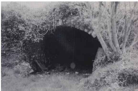
Le grand tunnel de la ferme Saint-Gervais à Dormelles
