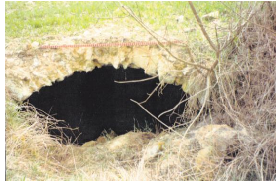
Le « petit tunnel » à Dormelles
