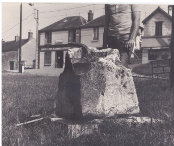
La base de croix lors de sa mise en place par le CRDMA de Saint-Mammès en 1978
