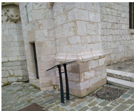
Regard de chaussée indiquant l'entrée de la galerie souterraine.
