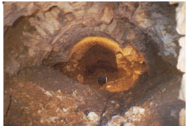
État de détérioration et de dangerosité du couloir.
