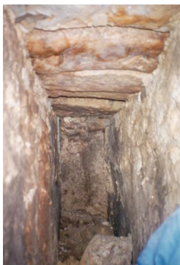
galerie de visite du puits en direction du nord
