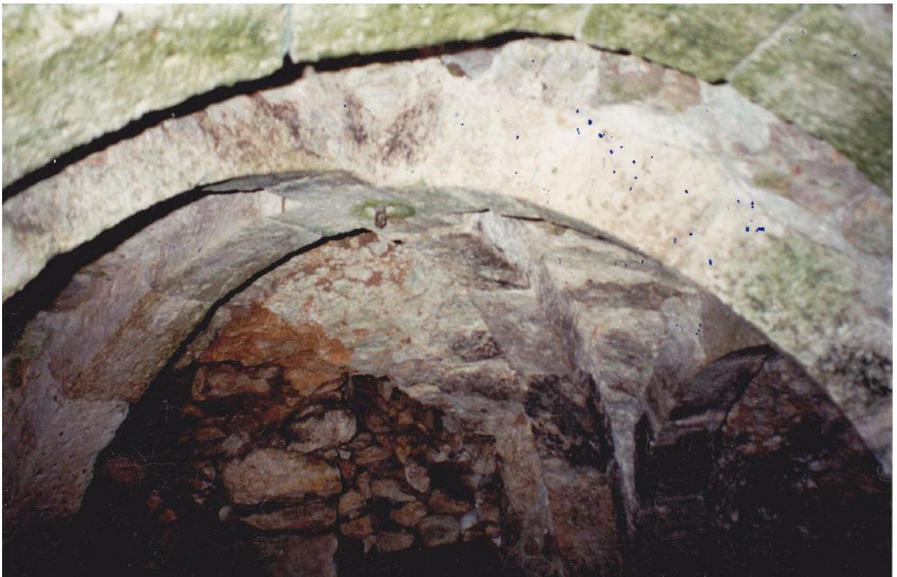
Croisée d'ogives et vestiges des alvéoles
