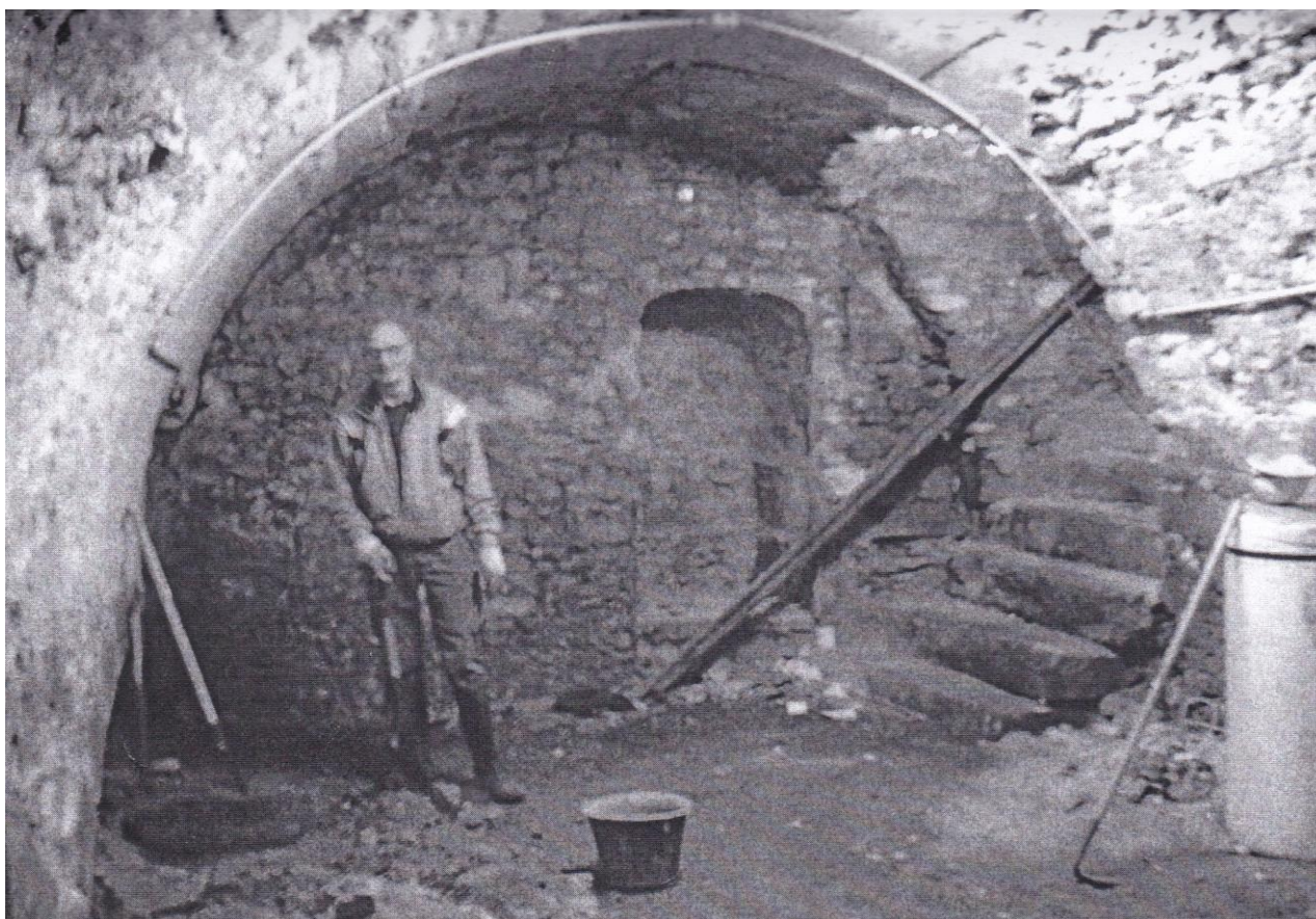
Premier espace voûté en berceau et percement muré au bas de l'escalier
