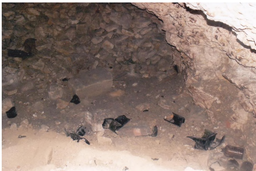
Cavité sous la rue Grande à hauteur du numéro 23
