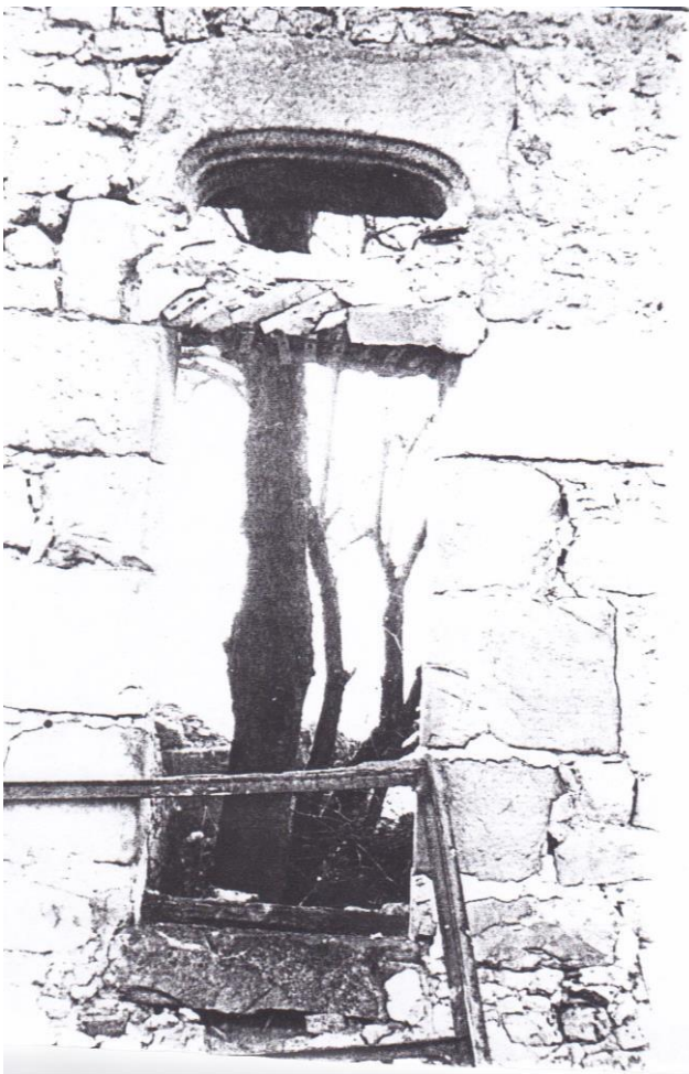
Le linteau de fenêtre encore en place
