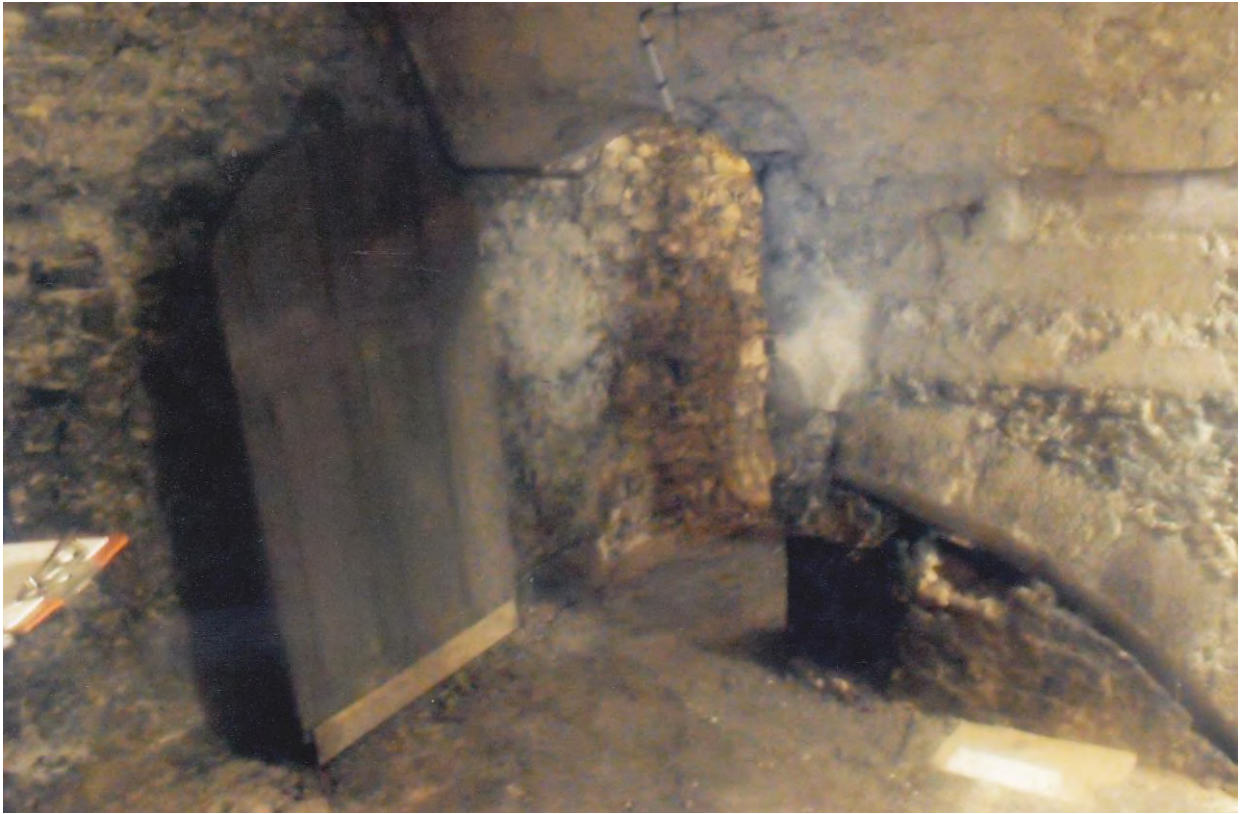
Niveau du sol exhaussé, arcade remblayée et brisée et percement postérieur d'une ouverture plus haute
