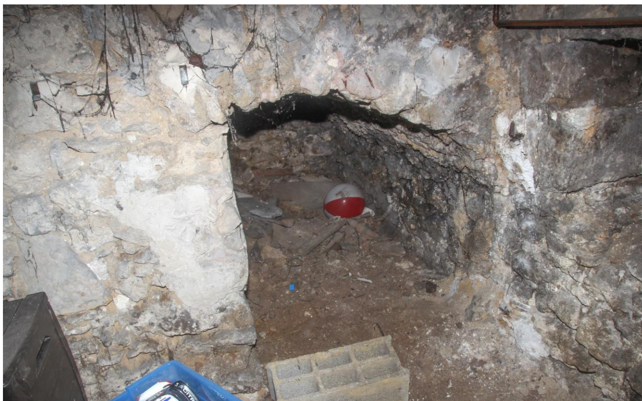
Accès au petit caveau
