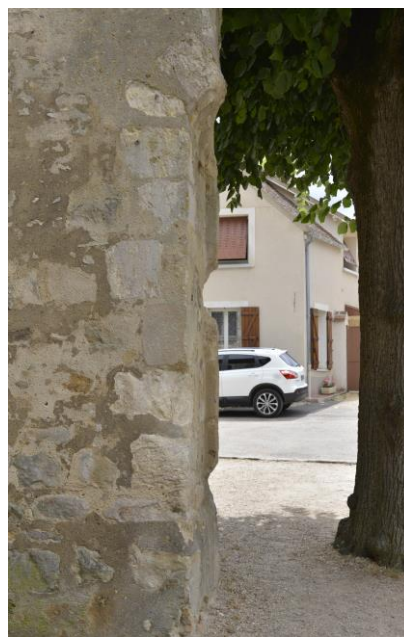
2 jambages de porte sud
